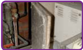
Conduit amiante-ciment
