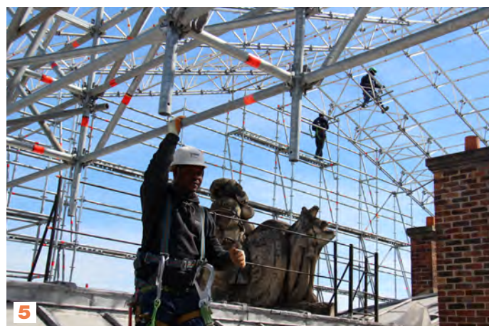
4-5. Vues du chantier intérieur et extérieur au mois de mai.
