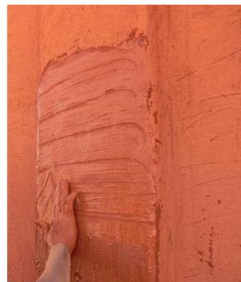
L'huile de lin est souvent utilisée dans la masse et en imprégnation des sols en terre crue. Ces recettes permettent de rendre les sols en terre plus résistants à l'eau et notamment de les laver facilement sans les altérer. Cependant, ce type de stabilisant réduit probablement la perméabilité à la vapeur d'eau, diminuant le caractère respirant de ces sols et enduits.
