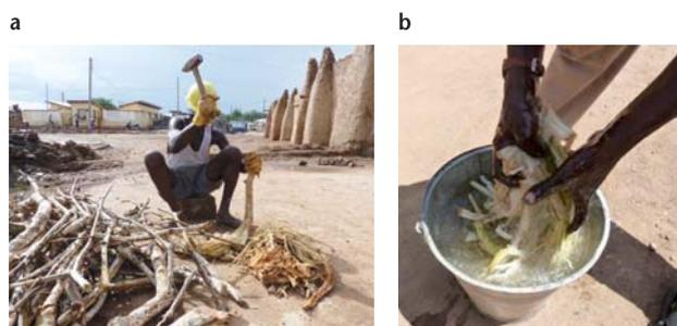
▲ **Figure 3.** (a) Au Ghana, des branches sont écrasées puis trempées dans l'eau, formant ainsi un gel. (b) Cette eau gluante est utilisée avec de la bouse de vache diluée comme eau de gâchage d'un enduit. © Sébastien Moriset / CRAterre-ENSAG
