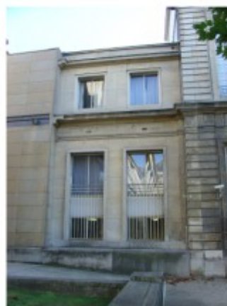
façade sur jardin du bâtiment des Stages en 2011
