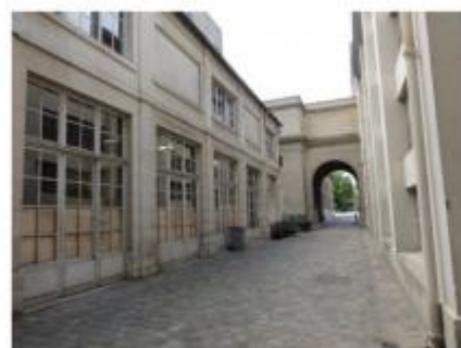
l'ancienne ruelle de la Roche en 2011
