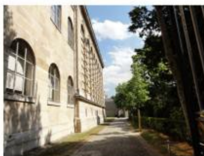
l'ancienne ruelle de la Roche en 2011
