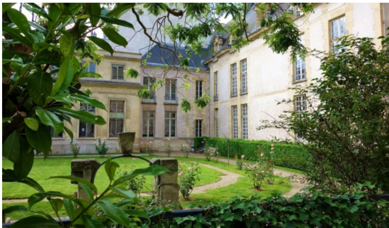
Imbrication entre l'Hôtel de Jaucourt et le bâtiment Chamson
