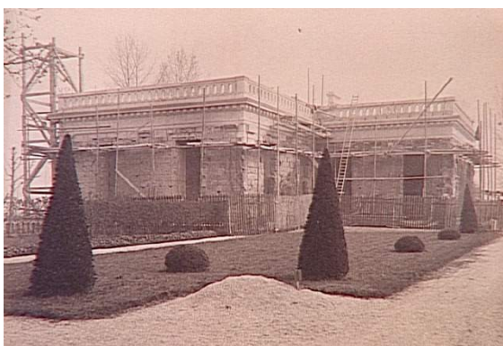
1930 – Travaux sur l'aile Nord
