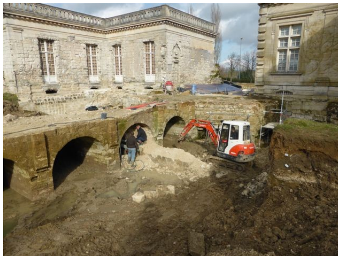
Pont à 4 arches sur la terrasse avant
