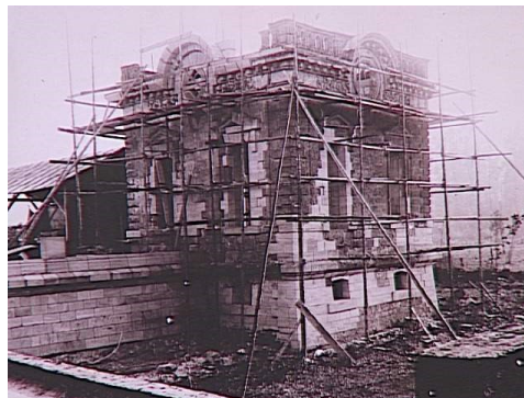
Les travaux sur le pavillon Sud
