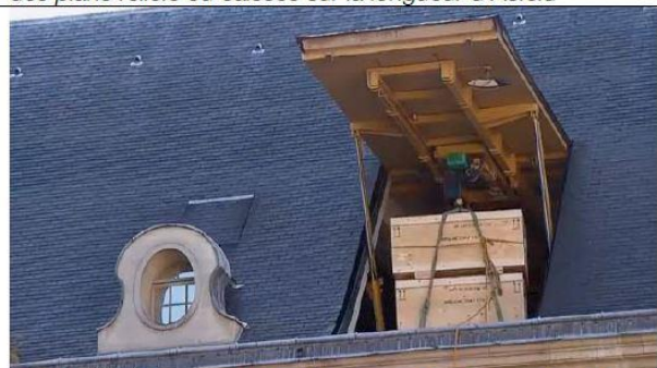
Ouverture à commande de la toiture avec système de palan donnant dans la cour de la victoire
