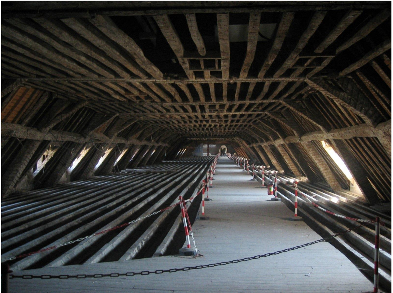
Vue de la galerie Louis-le-Grand (avant recoupement)
