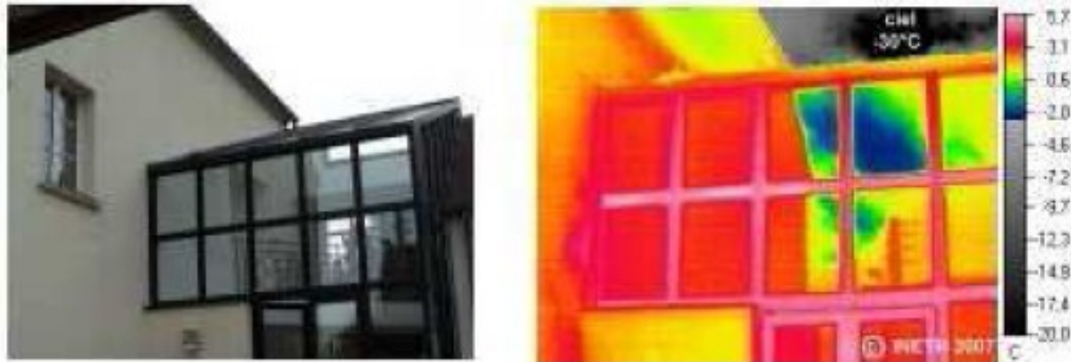
Figure 4. 16 (source Institut de la Thermographie)
