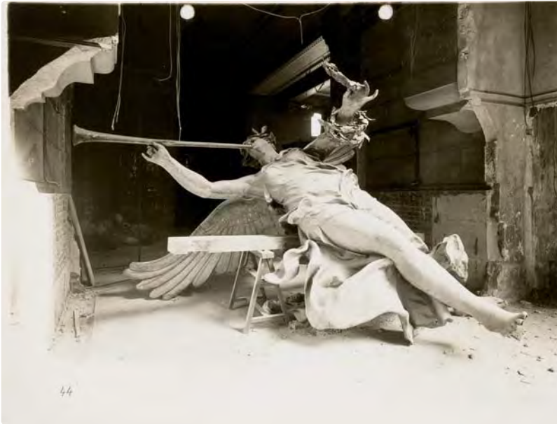
Exposition internationale de Paris, 1937, photographie de Baranger, « La démolition du Trocadéro », statue de la Renommée. Archives nationales, F/12/12114. Voir le projet « Replay » : http://replay.labex-arts-h2h.fr/
